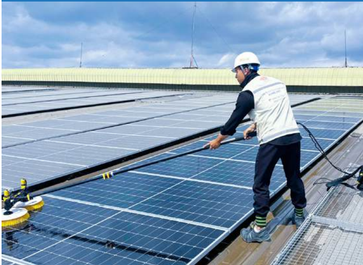
Vệ sinh bề mặt tấm pin
