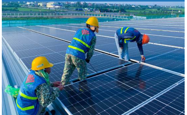
Kiểm tra chất lượng tấm pin
