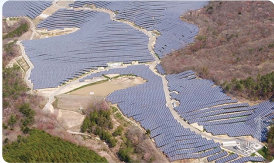
42.3MW, Japan Fukushima Solar cable
