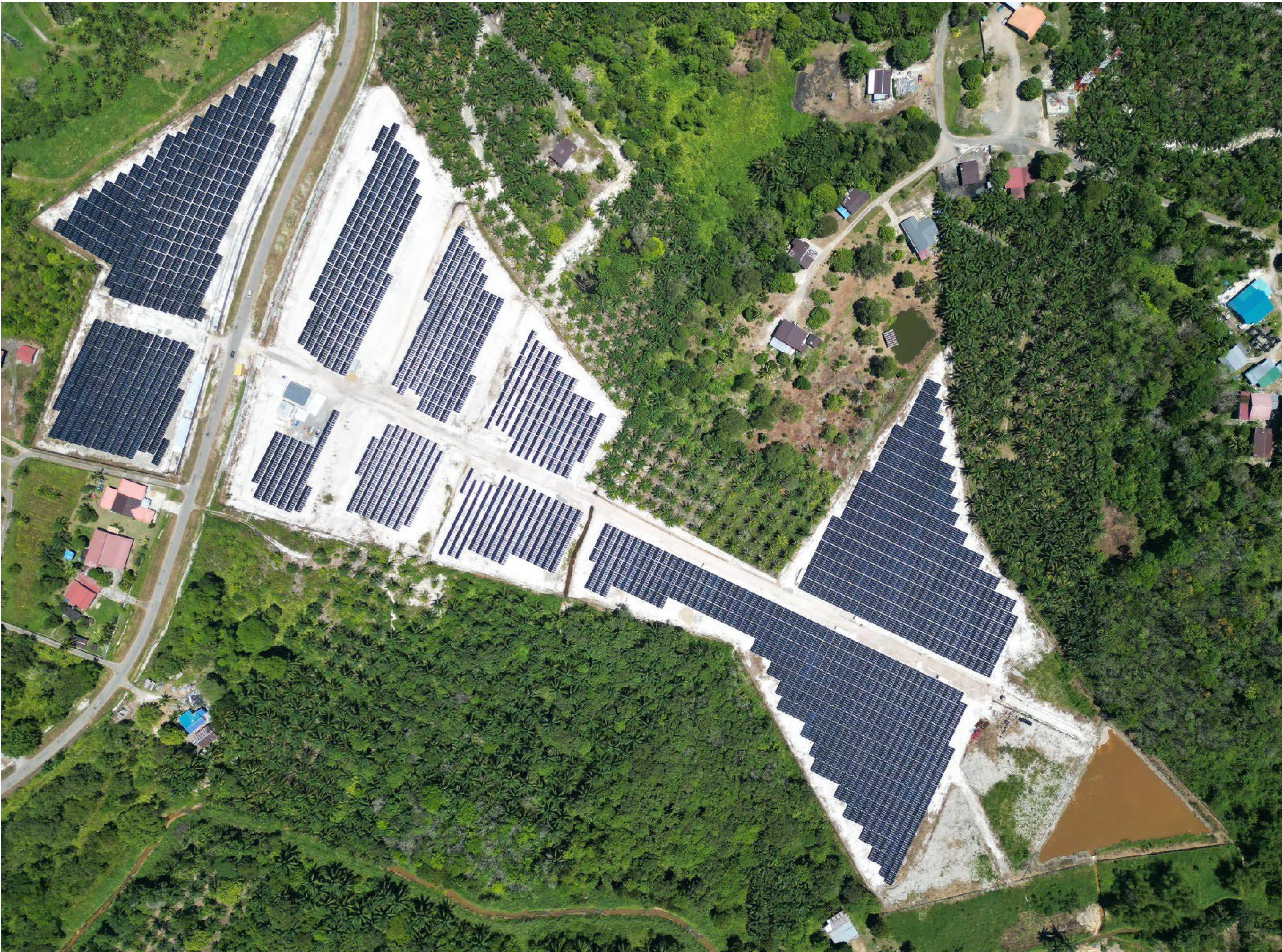
Beaufort, Sabah 7MW
