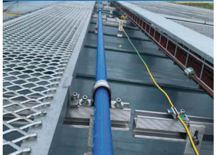
Hệ thống cấp nước vệ sinh
