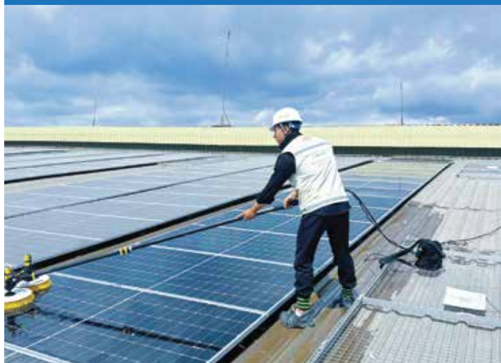
Vệ sinh bề mặt tấm pin
